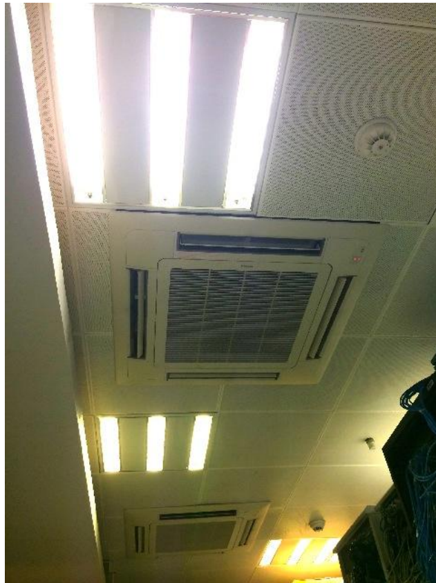
FP100XXXX; ABC 有限公司; 2 號辦公室; 天花式空調, DEF(品牌), XYX12345678(型號), 共 2 部; LED 9W T8 光管, DEF(品牌), XYX12345678(型號), 共 9 支; 攝於 2014-8-20
